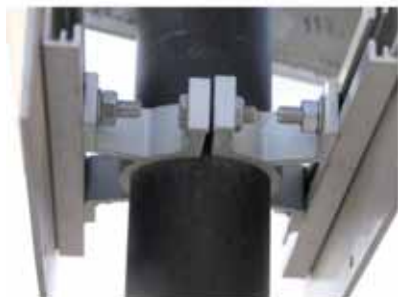
Exemples de fixations professionnelles sur poteau métallique
