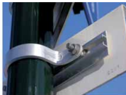
Exemples de fixations professionnelles sur poteau métallique
